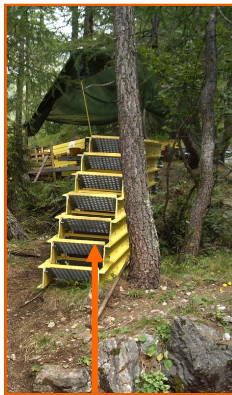
Elementi della scala di servizio da montare all'interno della galleria
