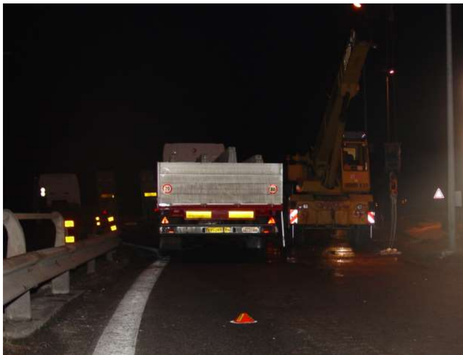
Figura. 1. Camion carico di new jersey da scaricare a sinistra e autogrù a destra.
