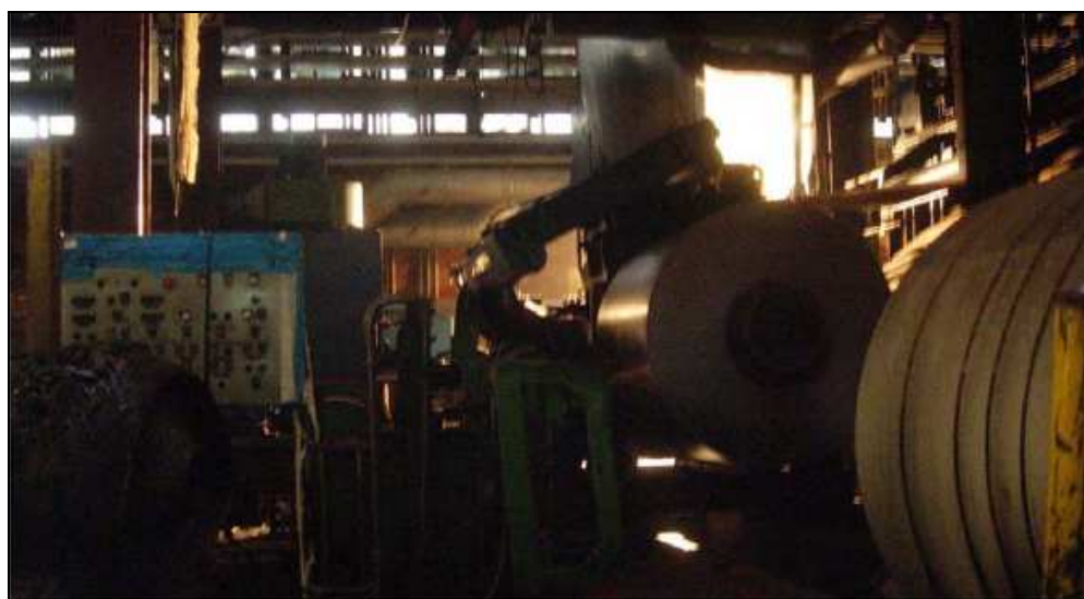
Zona dell'aspo 1 con la cabina del pulpito principale alle spalle: immagine estratta dalla consulenza tecnica di B.V. e Q.B.
