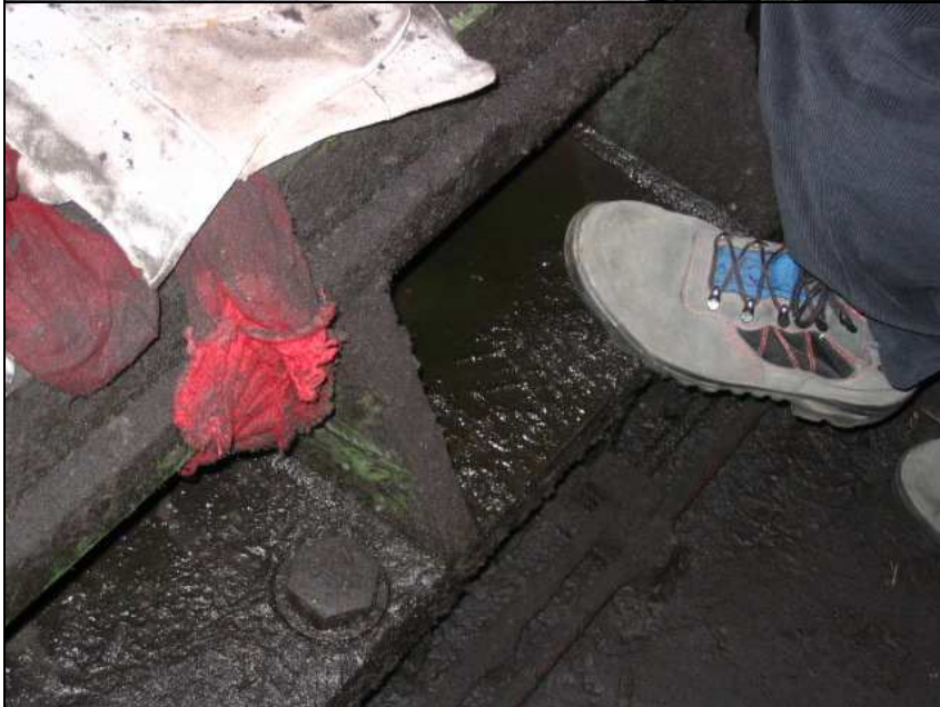
Linea 4, Torino: accumuli di materiale oleoso
