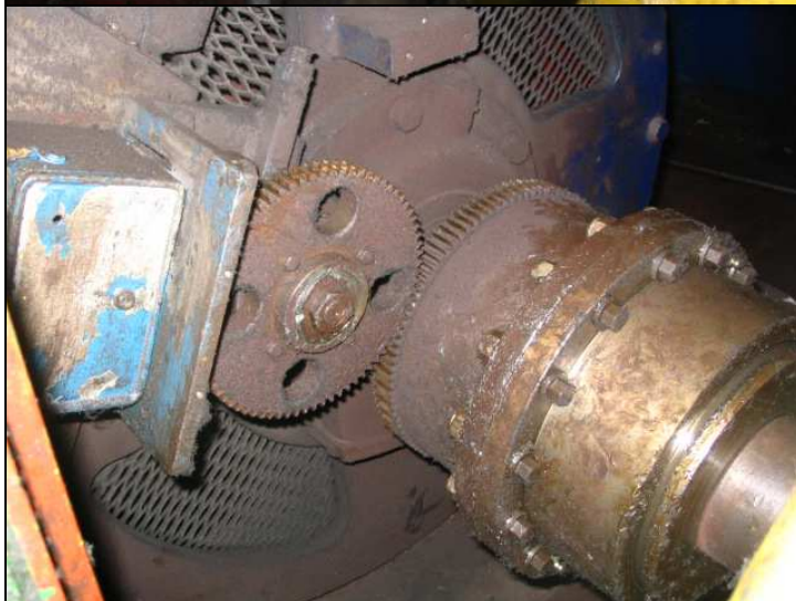
Linea 4, Torino: ingranaggi accessibili
