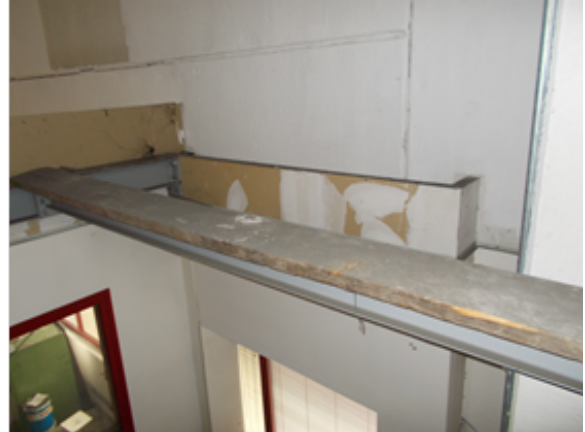
Figura 3: Asse da ponte appoggiata sulla putrella
