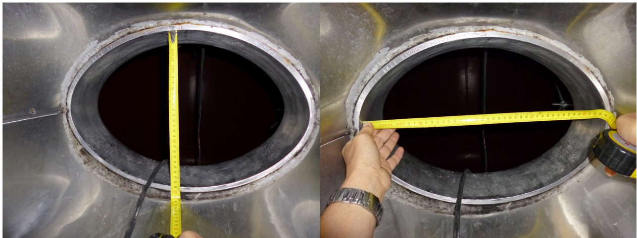
Figura 2: apertura ovale dell'autoclave "a passo d'uomo".
