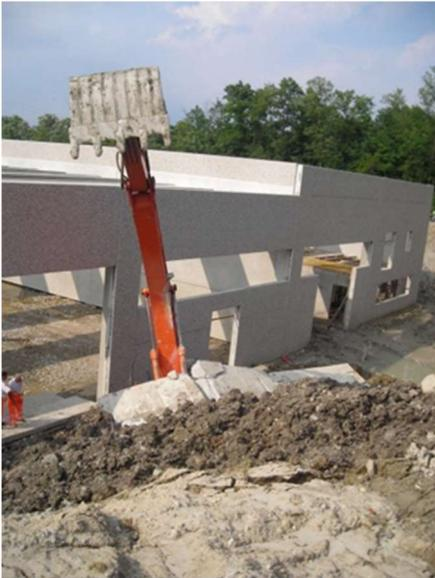
Figura 1: l'escavatore ricoperto dalla terra e dai resti del muro caduto
