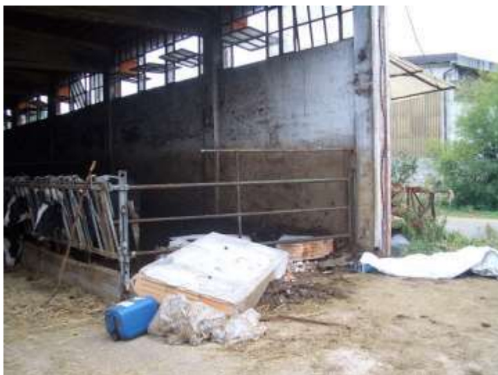
Figura 1: setto in muratura franato
