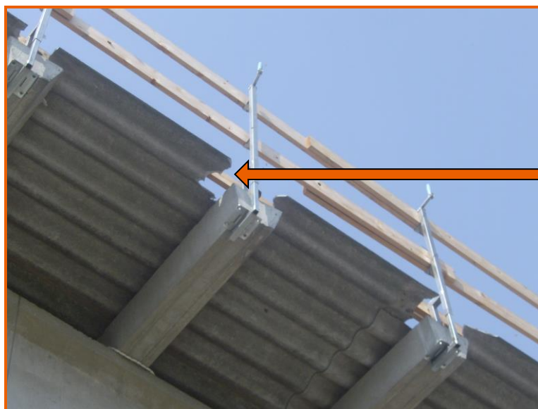
Particolare delle demolizioni delle parti esterne delle lastre di copertura in cemento amianto
