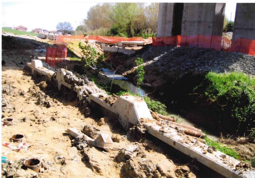
Figura 1. Area di cantiere con basi di micropali
