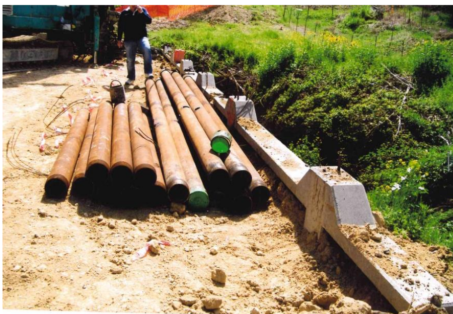
Figura 4. Spezzoni di tubi metallici che vanno a costituire l'armatura dei micropali
