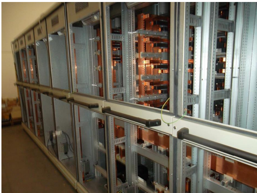
Figura 2. Parte posteriore di un armadio elettrico con le bandelle in rame nudo; al termine delle operazioni tutta la superficie sarà chiusa da pannelli isolanti.
