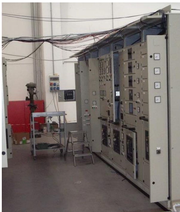
Figura 1. Parte frontale di un armadio elettrico con i pannelli montati e i componenti già posizionati
