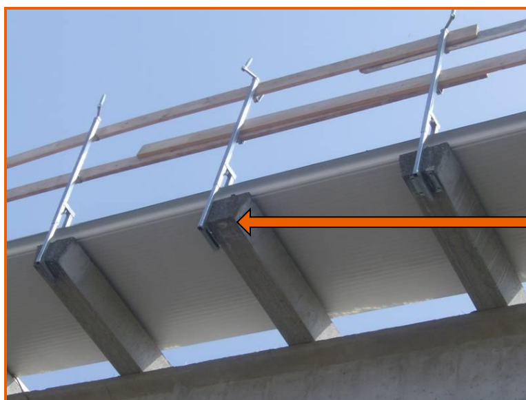
Particolare del fissaggio inadeguato di un montante
