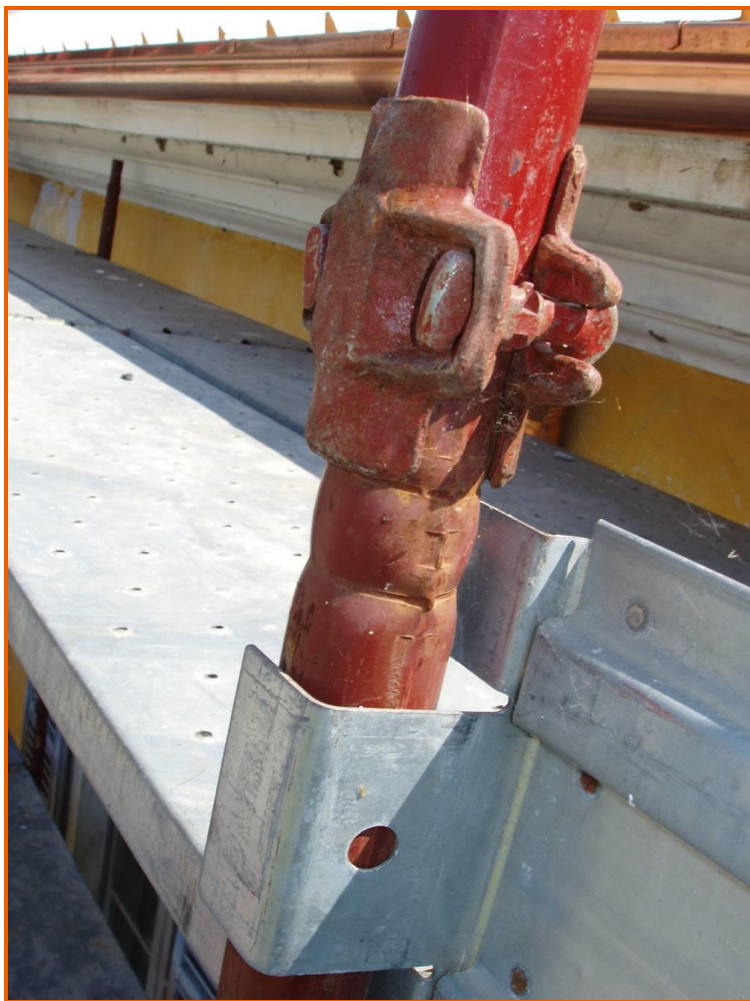
Aggancio della tavola fermapiiede al montante del ponteggio
