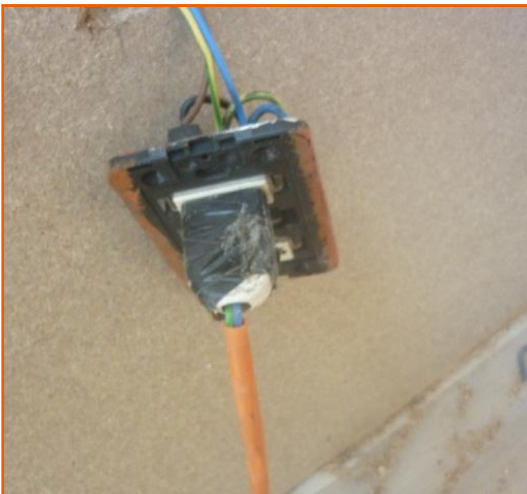
Figura 5: spina di alimentazione nastrata con nastro isolante; il supporto della presa era fuori dalla scatola di derivazione a muro con cavi elettrici a vista.
