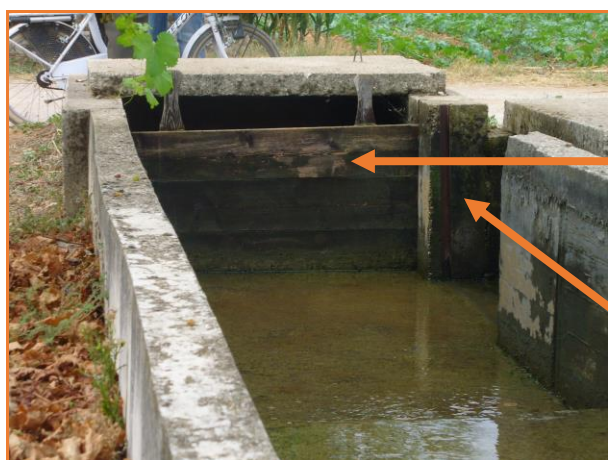
Paratia della serranda del canale sifonato (per permettere l'attraversamento della strada) che irriga il terreno di Terenzio
