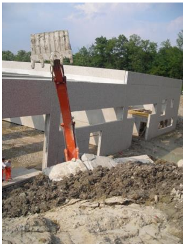
Figura 1: Escavatore ricoperto dalla terra e dai resti del muro caduto
