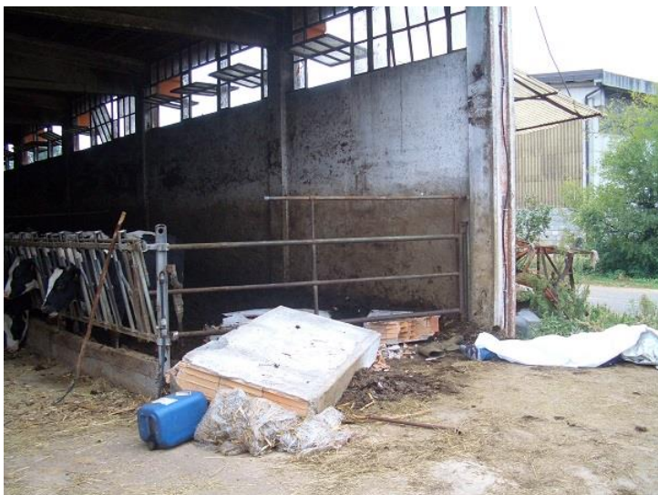
Figura 1: setto in muratura franato
