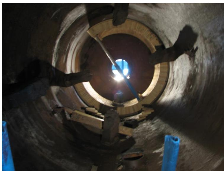
Alla ditta per cui lavorava Amid erano stati commissionati alcuni interventi di manutenzione. I lavori da effettuare consistevano nel rifacimento dello strato isolante, costituito da mattoni refrattari, all'interno del forno rotativo nel reparto fonderia. I lavori erano iniziati il giorno precedente l'infortunio.
