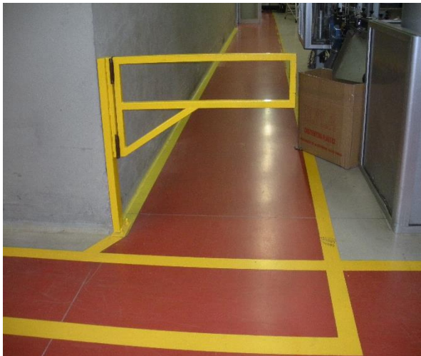
Figura 7. Evidenziazione delle barriere fisiche che sono state inserite per segnalare ed evitare il contatto con i carrelli elevatori
